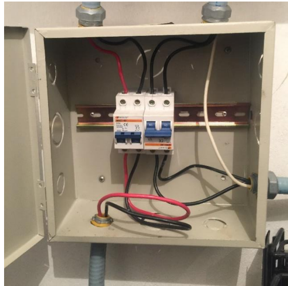
Fotografía 19. Sistema de transferencia manual. Fuente propia
