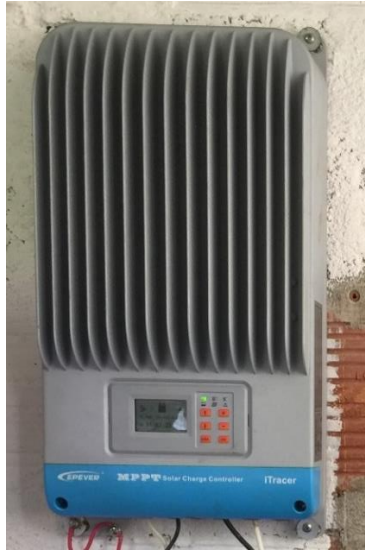
Fotografía 2. Controlador MPPT. Fuente propia.
