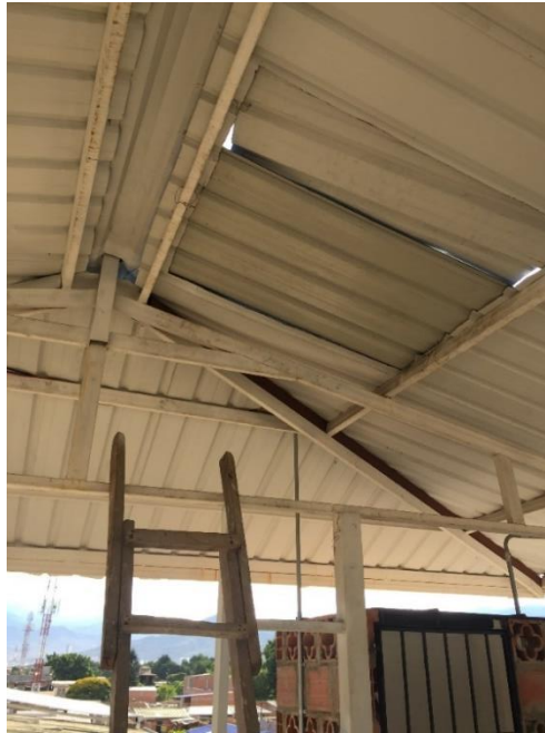
Fotografía 12. Acceso al techo. Fuente Propia
