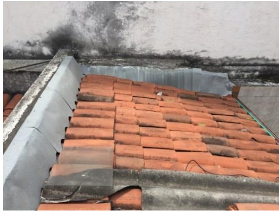
Fotografía 6. Techo balcón de gerencia (11:00am)
