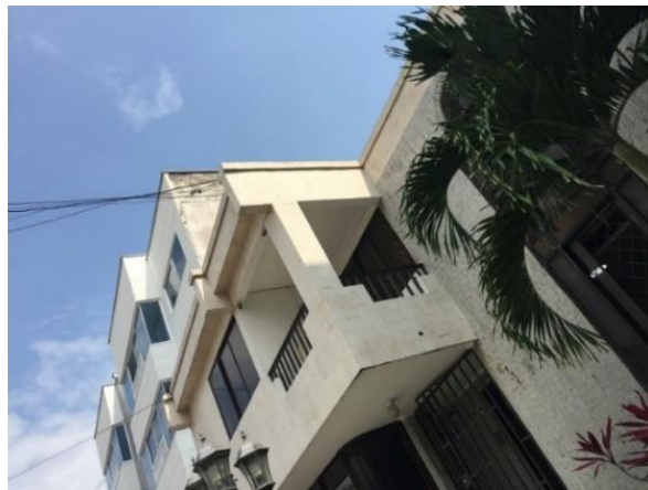
Fotografía 11. Techo balcón principal (2:30pm)
