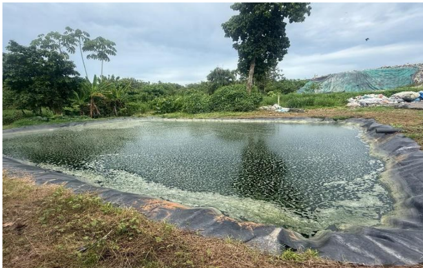
Figura 10. Laguna de homogenización en el relleno sanitario Buchelli
