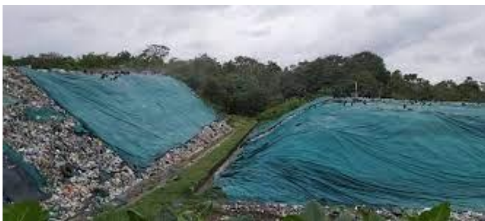
Figura 14. Celda de Operación Relleno Sanitario de Bucheli en el municipio de Tumaco Nariño.
