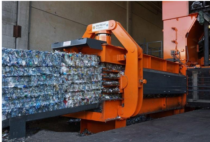
figura 19. Sistema de compactación de RSM
