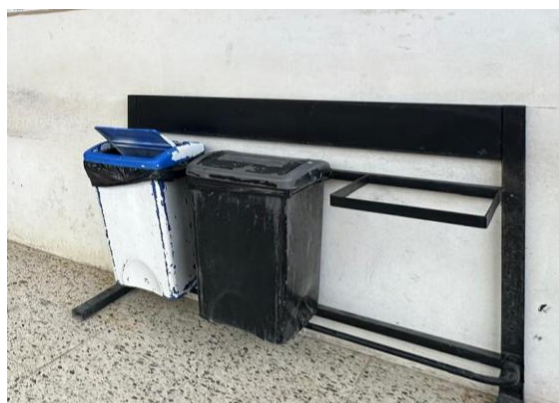
D. Punto ecologico incompleto, recipientes deteriorados, sin información
