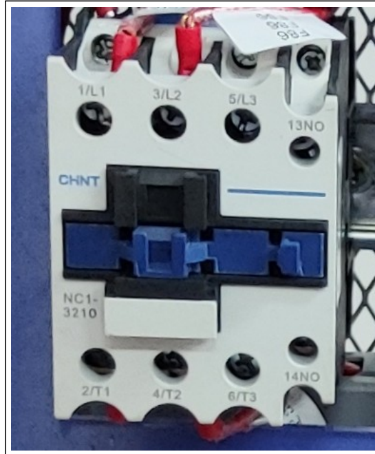
Figura 12: Contactor. Fuente: Propia.
