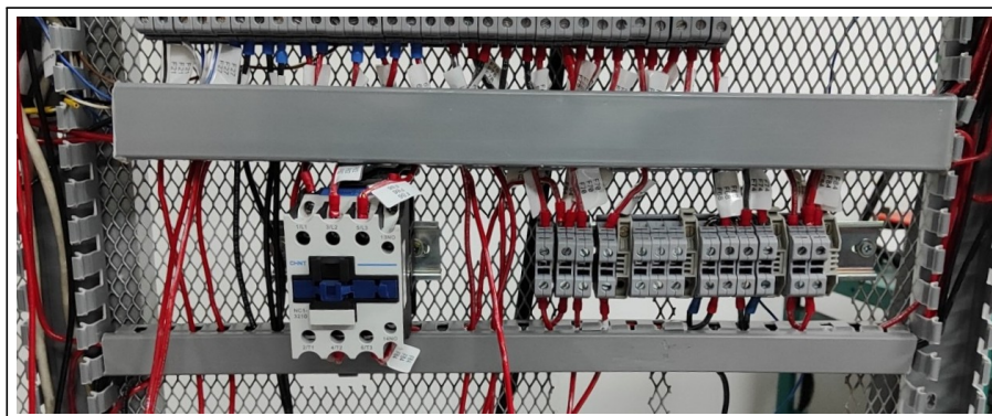
Figura 44: Canaletas nuevas. Fuente: Propia.
