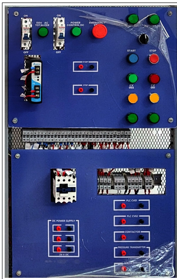
Figura 31: Tablero de acrílico nuevo. Fuente: Propia.
