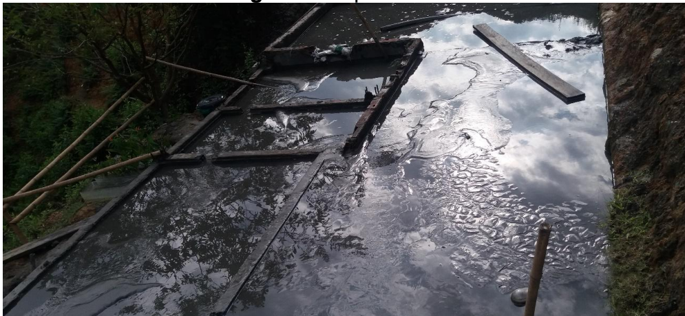
Imagen 4. Diques de colas
