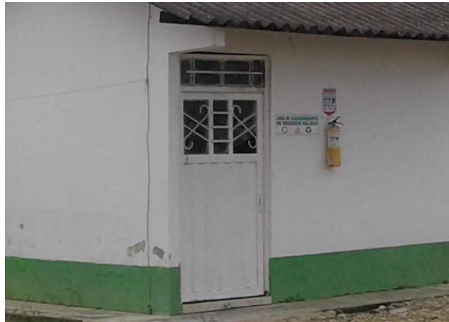
Imagen 28: Puerta de Acceso al Área de Almacenamiento y Señalización
