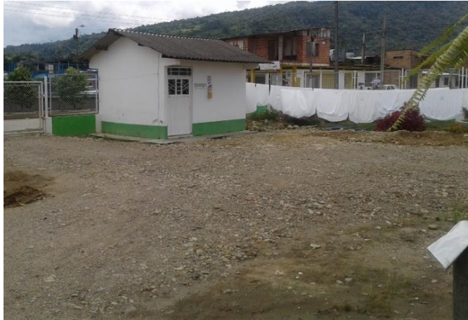
Imagen 22: Área de Almacenamiento Central de Residuos Hospitalarios
