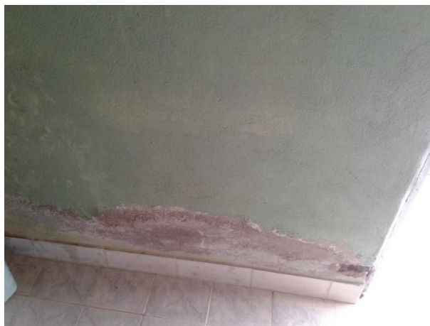
Imagen 23: Paredes en mal estado del Área de Almacenamiento Central de Residuos Hospitalarios
