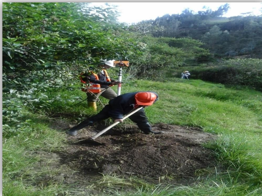
Figura 17. Relleno de los apique una vez localizados
