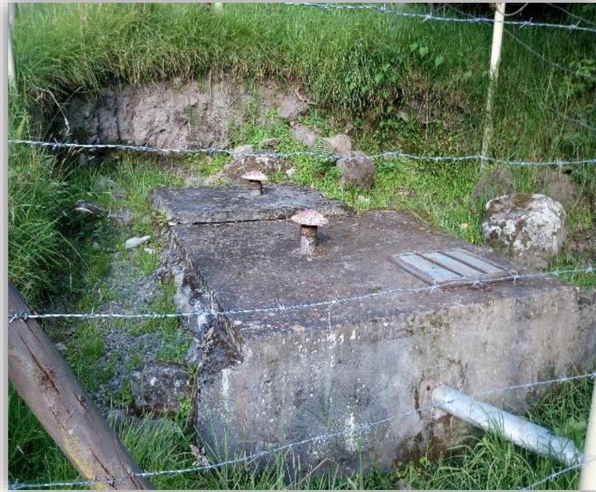
Figura 25. Captación por Manantial de Fondo 1
