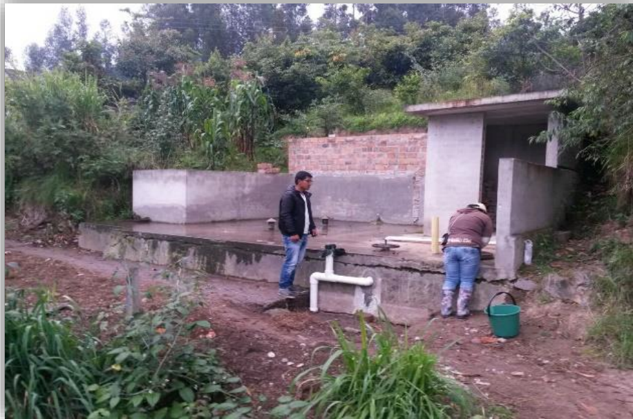
Figura 35. Tanque sin cerca de protección
