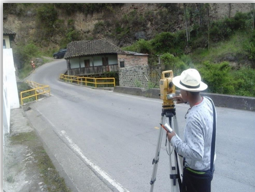
Figura 20. Topografía de referencia de la vía que comunica al municipio del Contadero Nariño
