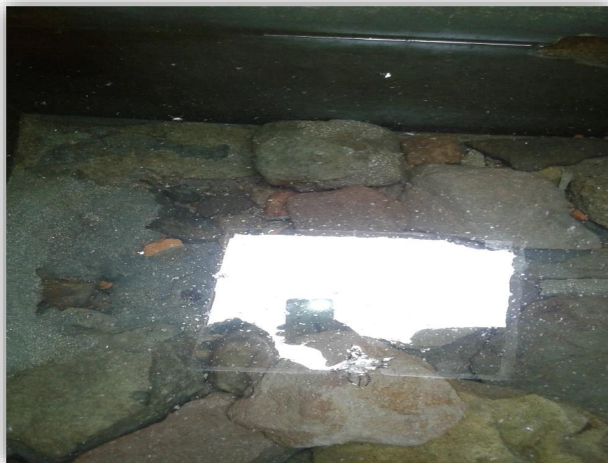
Figura 27. Fondo de la captación 2
