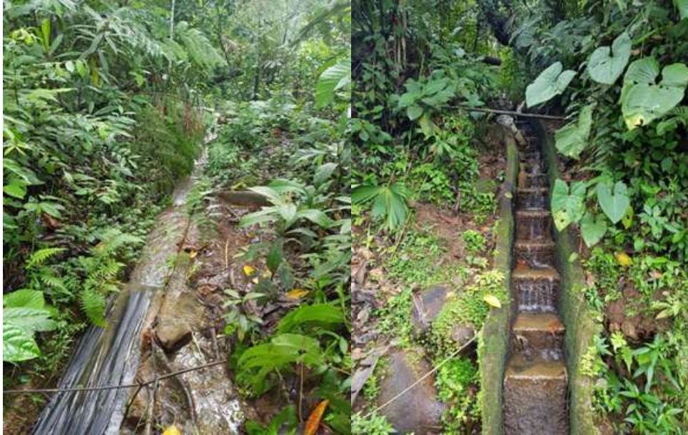
Fotografía 9. Sistema de pre tratamiento estación piscícola
