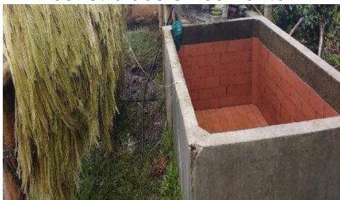
Figura 27. Tanques de lavado contruidos en cemento.
