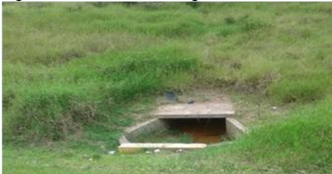
Figura 29. Vertimiento de aguas residuales
