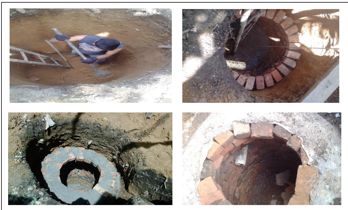
Figura 6. Construcción del Pozo de Absorción.
