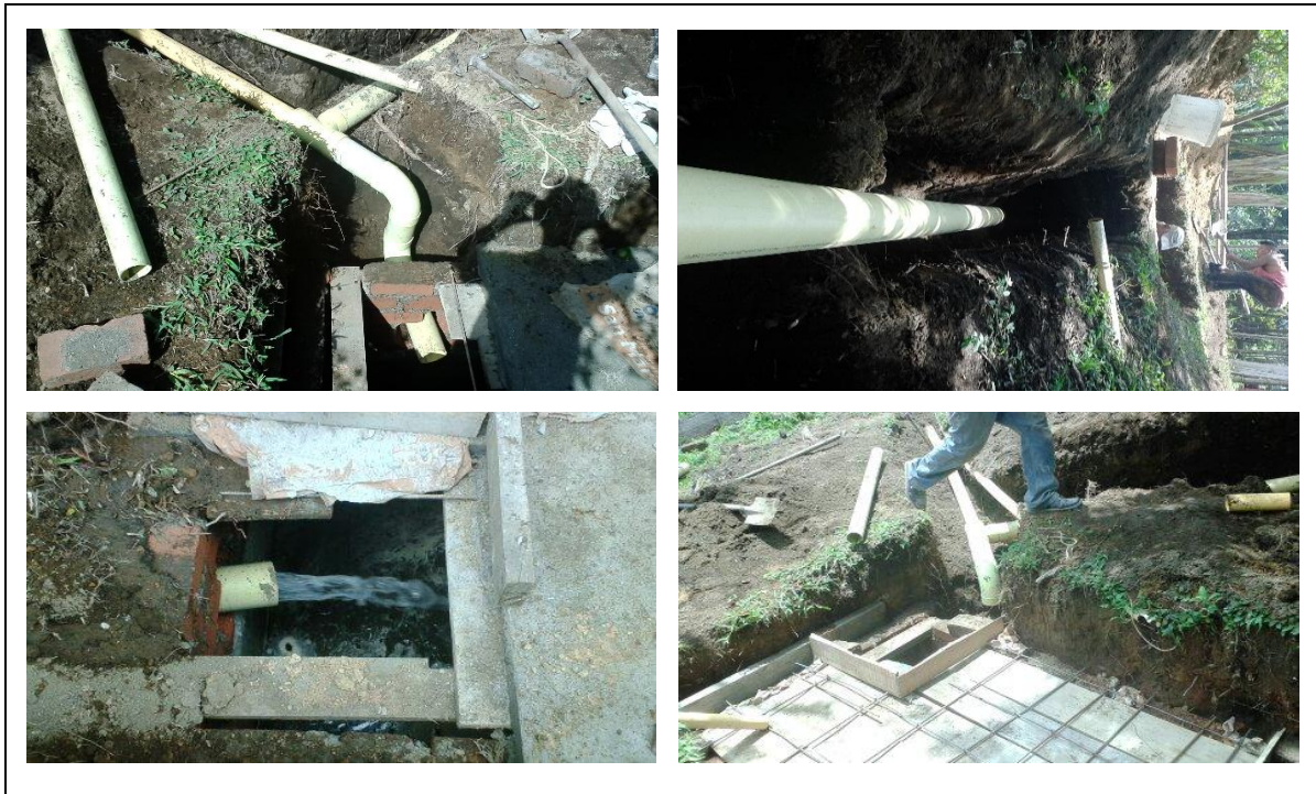
Figura 9 Instalación Hidráulica del Tanque Séptico
