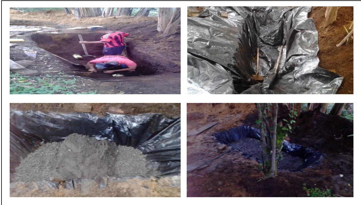
Figura 4. Construcción de humedal
