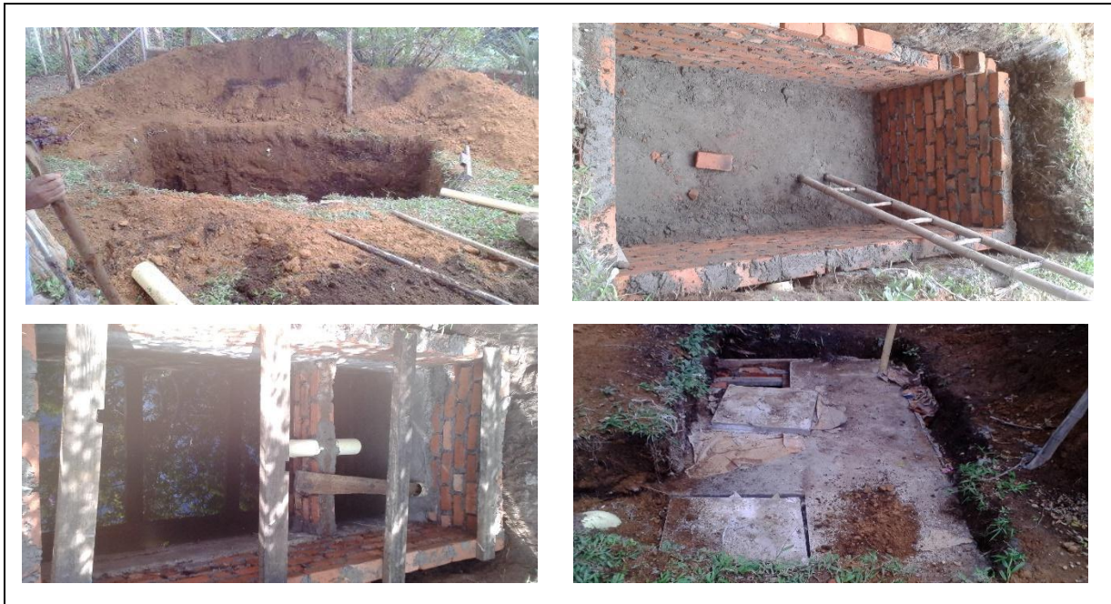
Figura 3. Construcción del Tanque Séptico.
