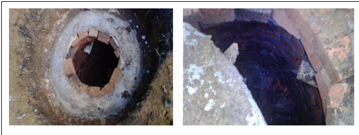
Figura 11. Pozo de absorción terminado
