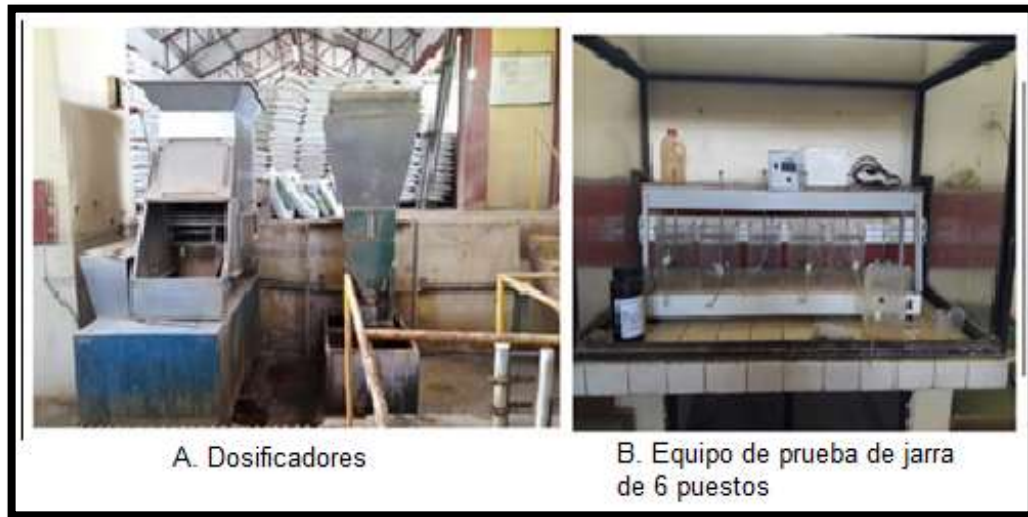
Imagen 12. Equipos y dispositivos área de potabilización
