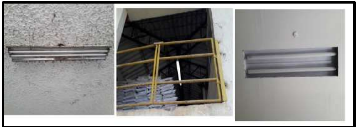
Imagen 13. Sistema de iluminación área de potabilización
