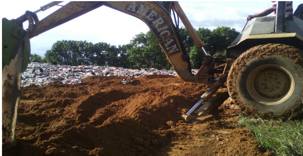
Ilustración 10. Extracción de material de cobertura; fuente propia
