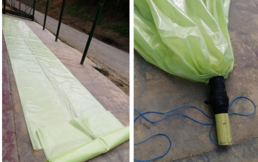
Figura 14. Preparación bolsa plástica y amarre de los extremos.
