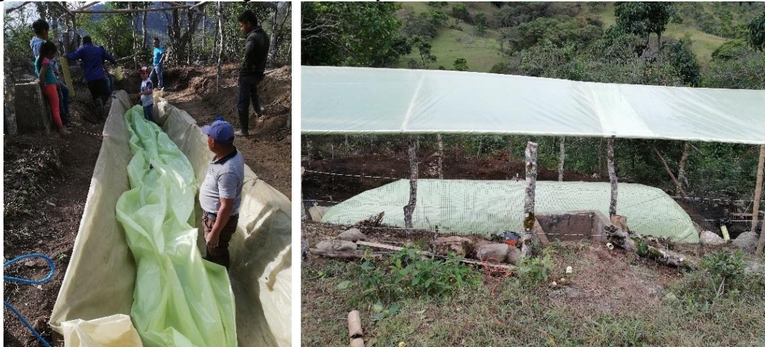
Figura 16. Instalación biodigestor, techo y cerramiento.
