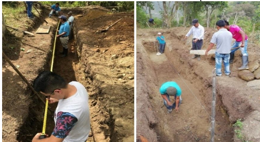
Figura 13. Excavación de la fosa con las dimensiones requeridas.
