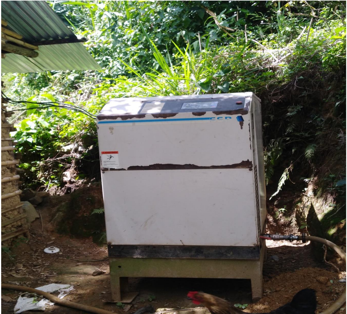
Foto 6. Compresor bocamina la Yireth
