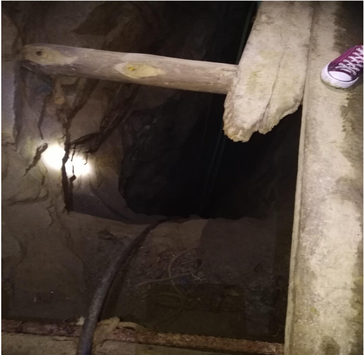
Foto 5. Clavada bocamina las Lajas
