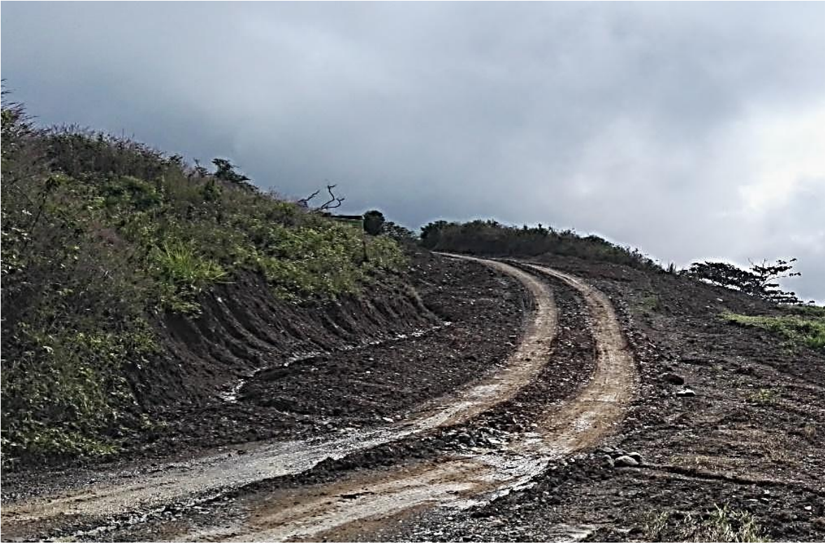
Figura 16. Zanja Perimetral a lo largo de la vía de acceso. Tomada por: Kevin Bastidas, 2018
