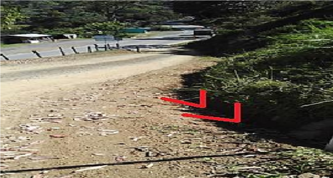
Fotografía N°5, Cunetas Perimetrales, Tomada en el año 2018 por Kevin Bastidas, En Vía de acceso a la cantera, MANEJO DE AGUAS DE ESCORRENTÍA: EL AGUA LLUVIA QUE SE ACUMULA DENTRO DE LA CANTERA, ES CONDUCCIDA POR LOS CANALES A LO LARGO DE LA MINA
