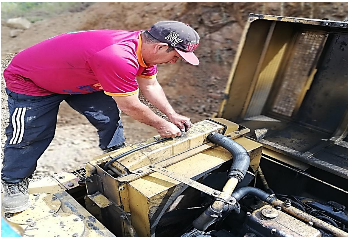
Figura 29. Mantenimiento periódico y preventivo de la maquinaria. Tomada por: Kevin Bastidas, 2018
