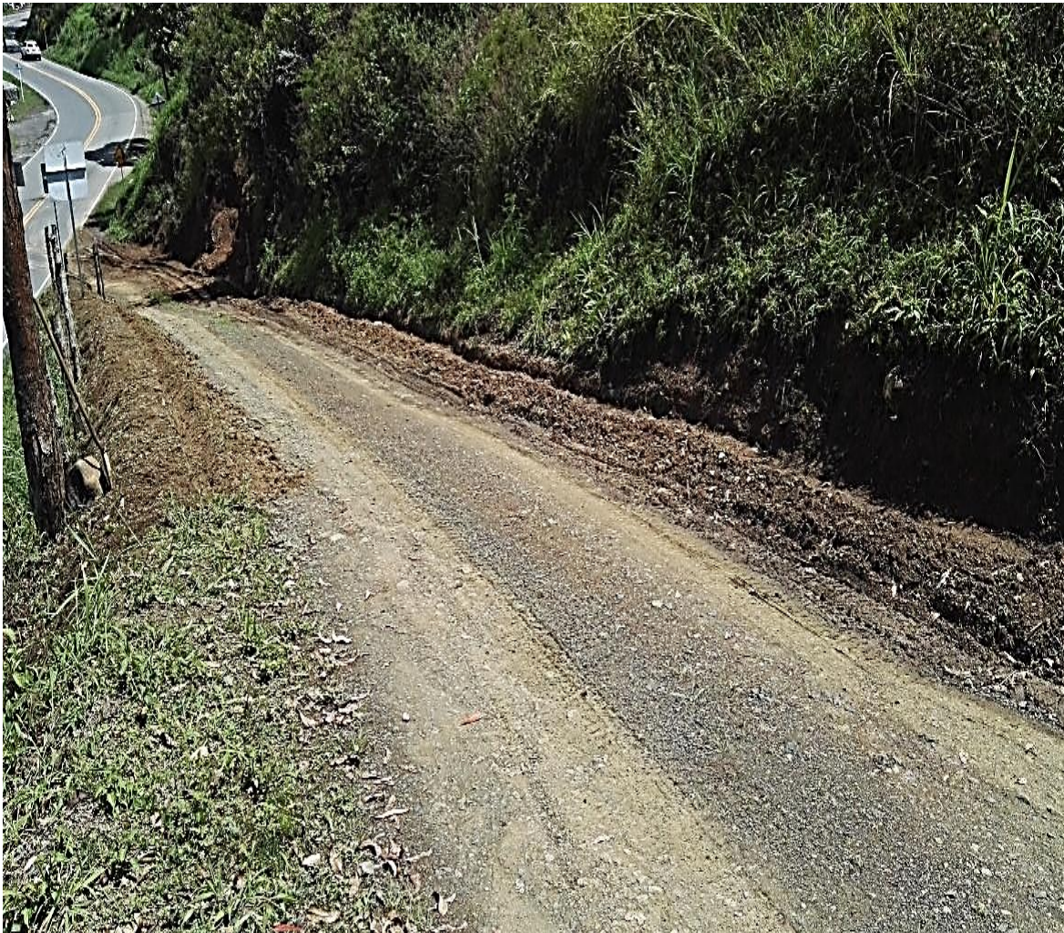
Figura 15. Cunetas perimetral vía principal de acceso hechas en “v”. Tomada por: Kevin Bastidas, 2018
