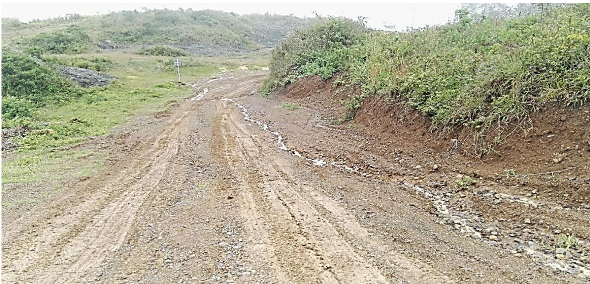
Figura 5. Aguas de escorrentía destilando por las vías de acceso. Tomada por: Kevin Bastidas, 2018
