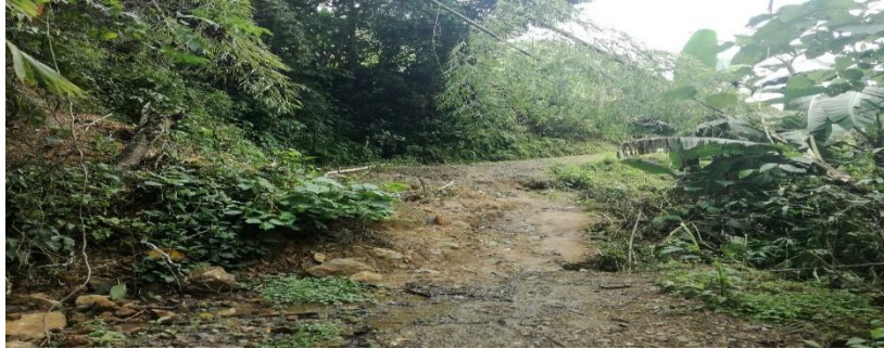
Ubicación Gavión del tramo Unión – La Calera.
