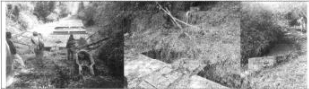
Vista General PTAR.
