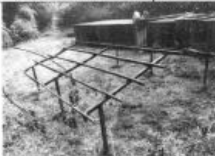
Estructura de secado de lodos.
