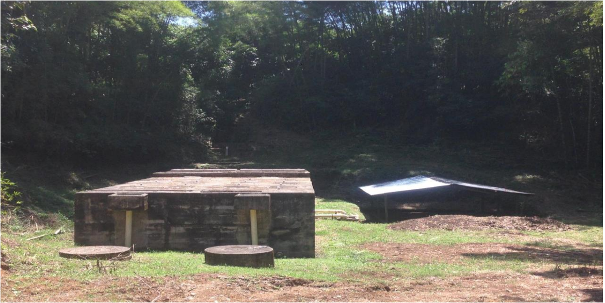
Figura 3. Estado inicial de la PTARD Nuevo Tambo. [25]
