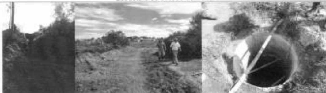
Obras de alcantarillado en ejecución.
