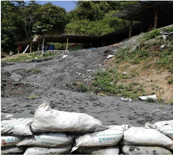
Escorrentía de lodos contaminados
