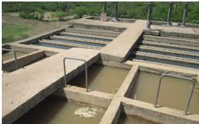
Planta de tratamiento para lodos
