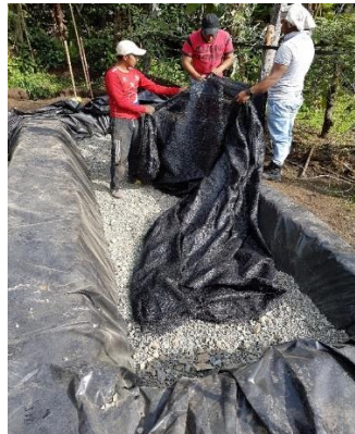
Imagen 17. Instalación de capa separadora (polisombra)
