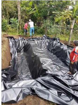
Imagen 16. Instalación de capa impermeable.
