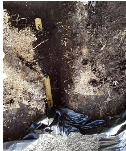
Imagen 18. Tubería de entrada y salida del humedal.
