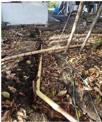
Imagen 18. Tubería de entrada y salida del humedal.
