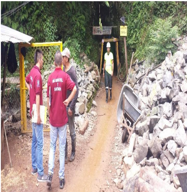
Figura 3. Proceso de excavación
