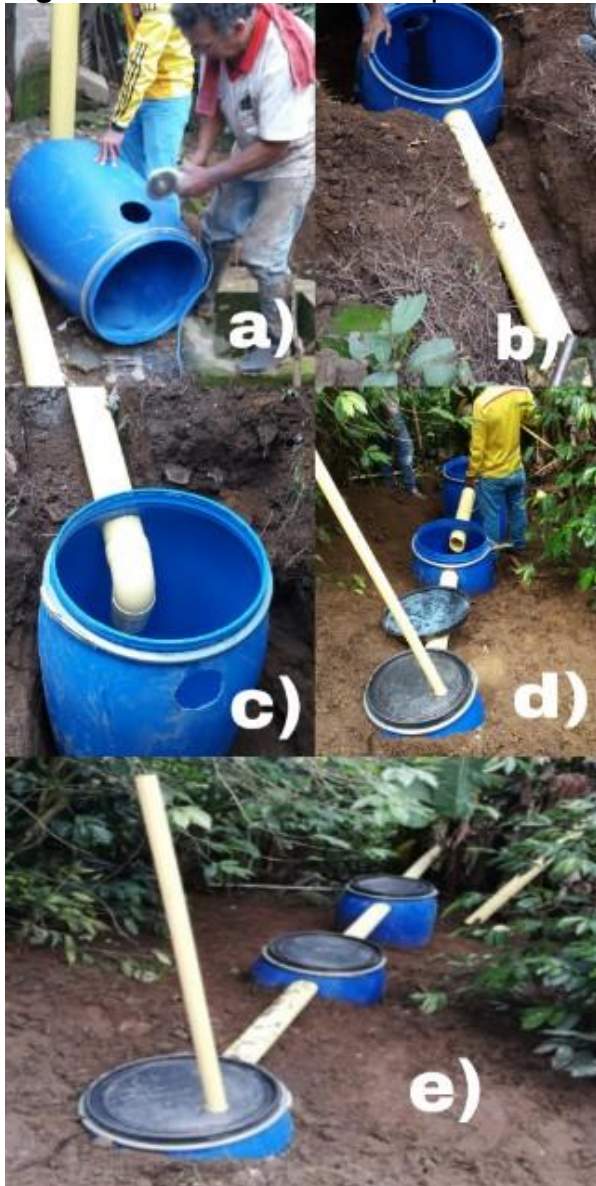
Figura 6. Construcción de la planta de tratamiento de aguas residuales porcícolas
