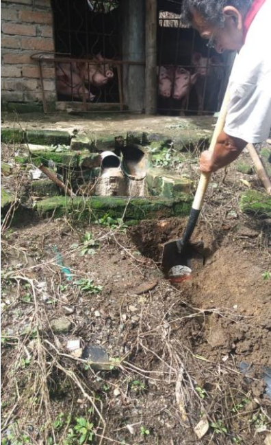
Figura 2. Construcción de la planta de tratamiento de aguas residuales porcícolas.
