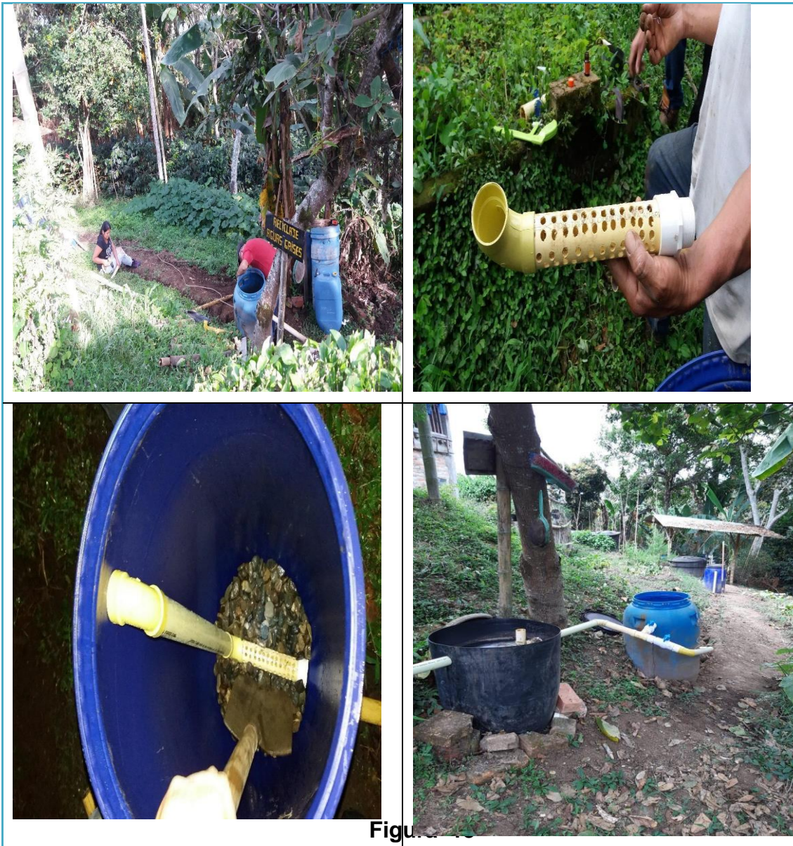
Registro fotográfico sistema piloto de tratamiento de ARD
