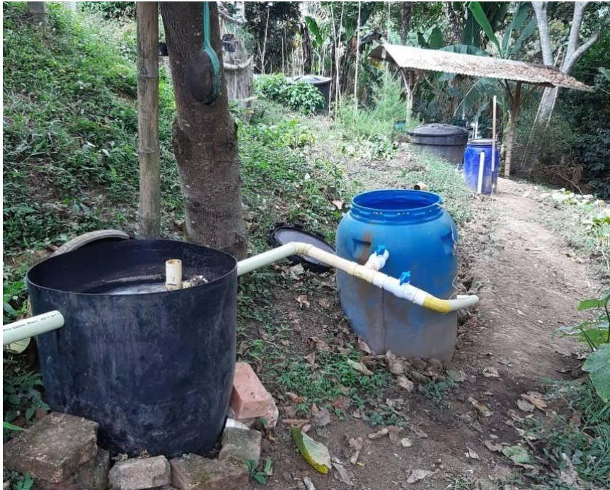
Figura 9. Sistema piloto de tratamiento de ARD. Fuente: Propia
