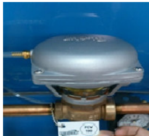
Figura 2.22: Válvula Neumática de Control de Flujo FCV 100. Fuente: Autor
