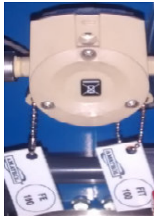
Figura 2.26: Sensor de Flujo FE 100. Fuente: Autor
