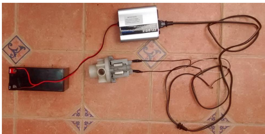
Fotografía 15: conexión entre la batería y la carga. Propia.
