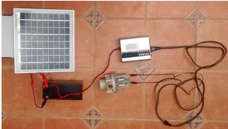
Fotografía 17: sistema energético en condiciones normales de trabajo. Propia.
