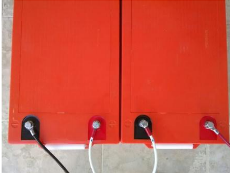
Fotografía 8: conexión real de las baterías. Tomada de [37].
