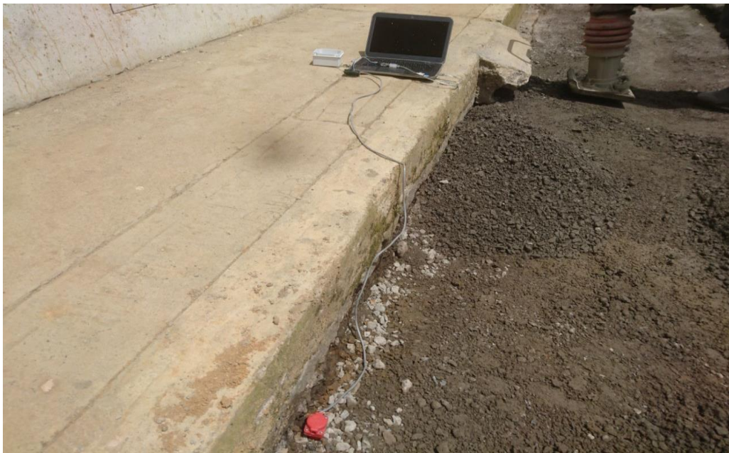
Figura 47: prueba pisón saltarín calle 1ª entre carrera 3ª y 2ª
