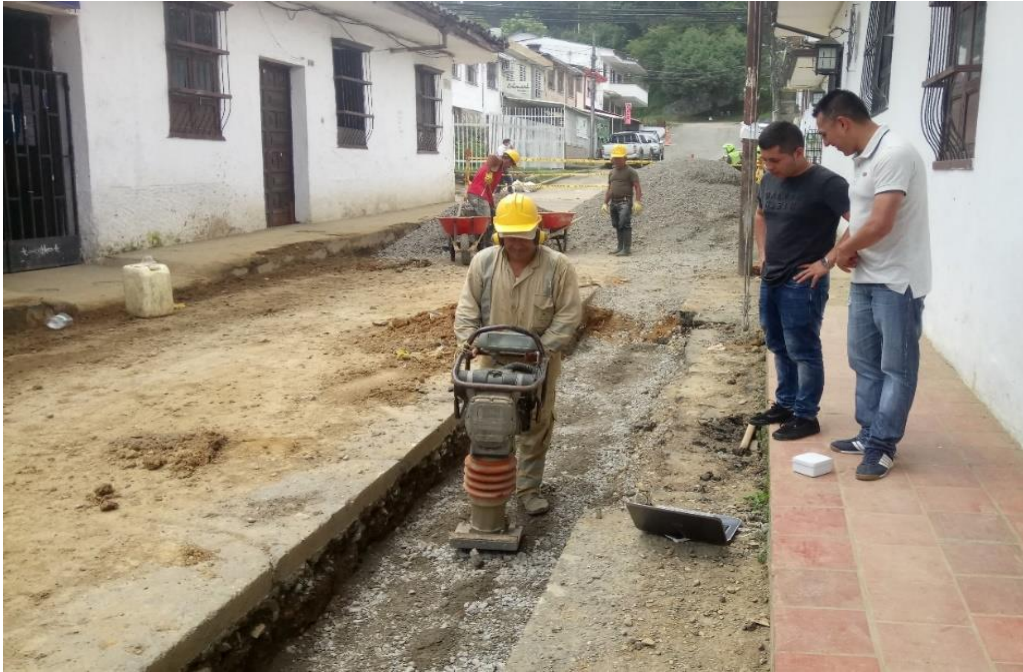
Figura 46: prueba pisón saltarín calle 1ª entre carrera 3ª y 2ª.
