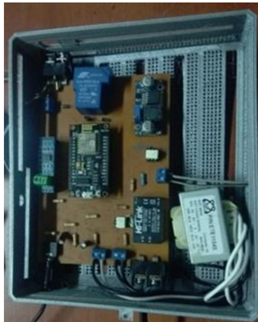
Figura 4-44: Estructura Final del Sistema principal.
