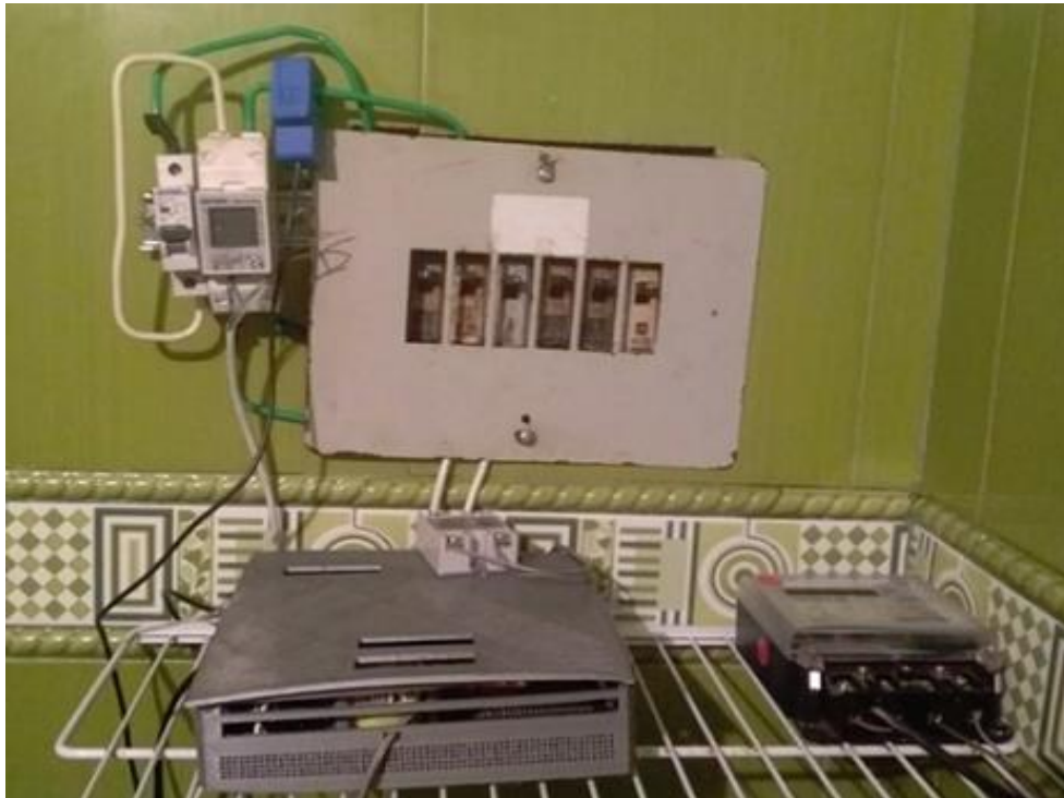
Figura 5-2: Implementación de la conexión del sensor de corriente no invasivo.
