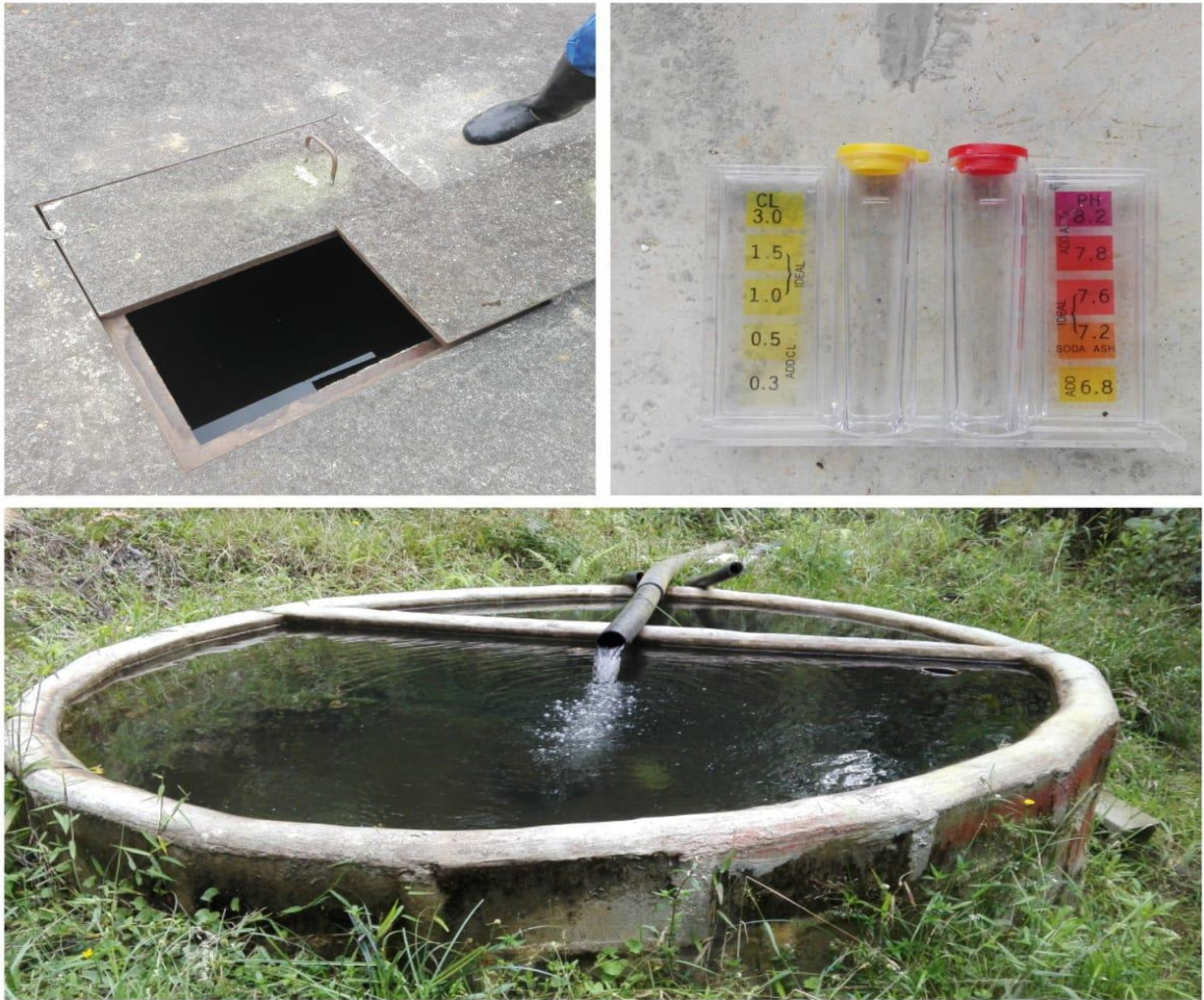
Imagen 26. Infraestructura del acueducto veredal Piedrahita-Animas
