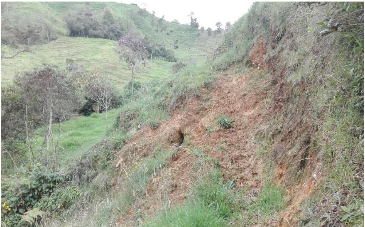
Imagen 17. Deslizamientos en las riberas de la quebrada la Guzmanana
