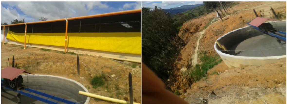
Imagen 10. Infraestructura para crianza de cerdos en la zona de influencia de la quebrada la Guzmaná
