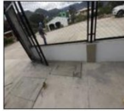
Ilustración 12. Cámara de salida de aguas residuales
