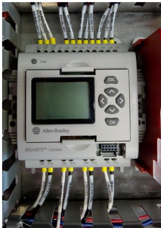
Figura 3-21: Conexión y marquillado del micro 810. Fuente: autor.
