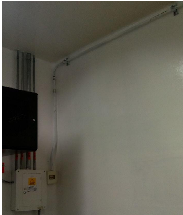
Figura 3-29: Instalación del tramo 1 de tubería. Fuente: autor.
