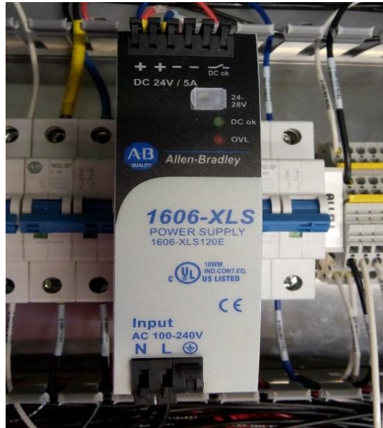
Figura 3-19: Conexión y marquillado de la fuente de voltaje. Fuente: Autor.
