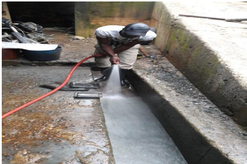
Imagen 6. Lavado de las instalaciones para realizar balance de masa
