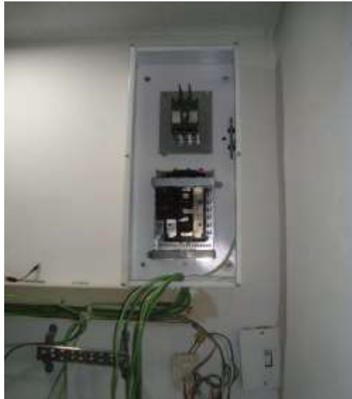
Fotografía 38. Instalación de tablero, cables y canaleta en el centro de datos.
