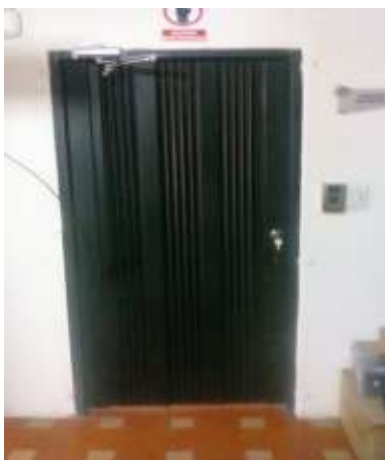
Fotografía 24. Puerta de acceso al centro de datos.
