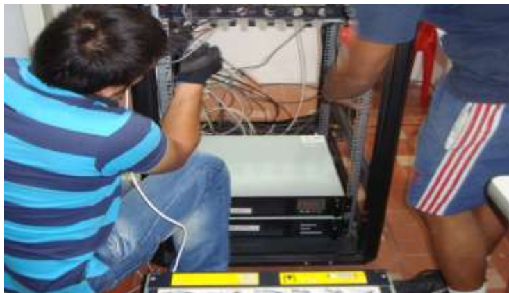
Fotografía 35. Montaje de UPS y batería en el Rack.
