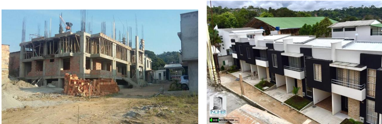
Figura 12. Avances de obra en Construcción de la Empresa
