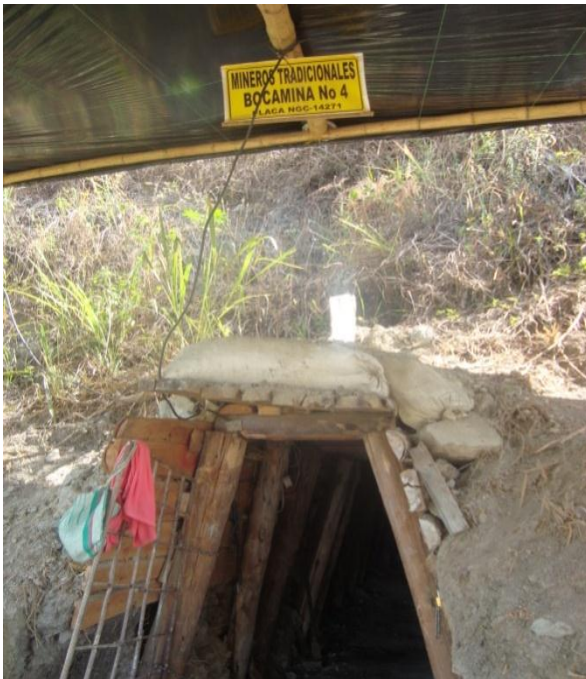
Fotografía No.3 Municipio de Rosas Cauca. Observación (Túnel de acceso para extraer material mineralizado)
