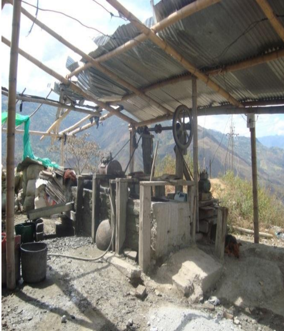
Fotografía No.1 Municipio de Rosas Cauca. Observación (Montaje utilizado para beneficio del oro).
