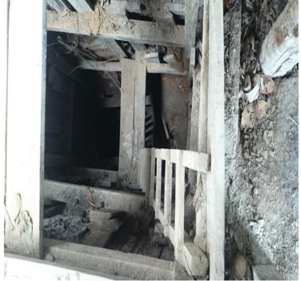
Fotografía No.2 Lugar: Vereda Frontino Alto Municipio de la Sierra Cauca. Observación (Socavón para extraer el material).
