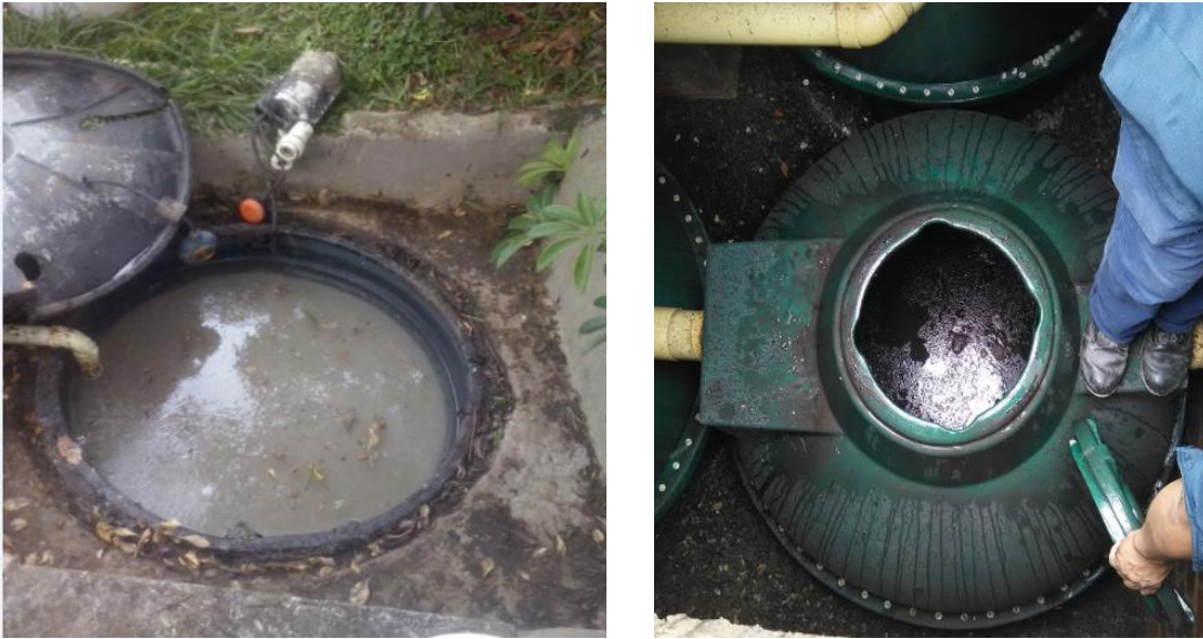
IMAGEN 5. Filtro anaeróbico
