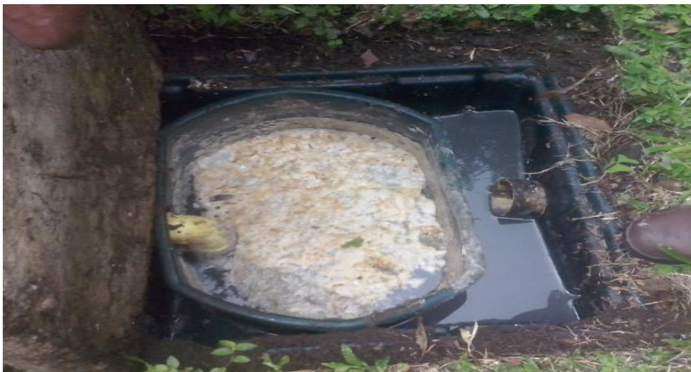
IMAGEN 1. Trampa de grasa prefabricada
