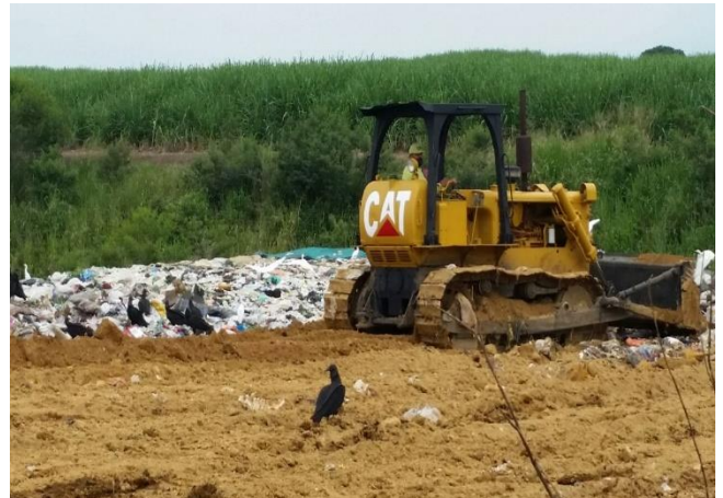
Imagen 2: Sitio de disposición final Celda transitoria, recubrimiento con “tierra amarilla”.
