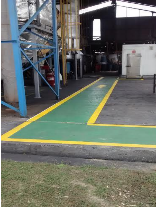
Donde deben pasar los trabajadores en el proceso de incineración.
