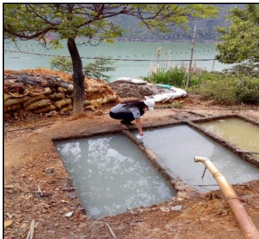
Figura 3. Colector de sedimentación de lodos
