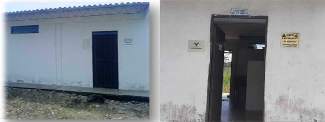
Figura 12. Unidad técnica de almacenamiento de la E.S.E. Hospital Orito
