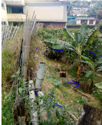
Foto 16. Deslizamiento Traslacional-B. El Bosque-Colegio
