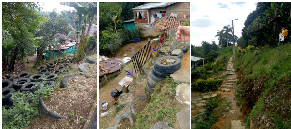
Foto 18. Inestabilidad y agrietamientos el B. Independencia, Cabecera Municipal
