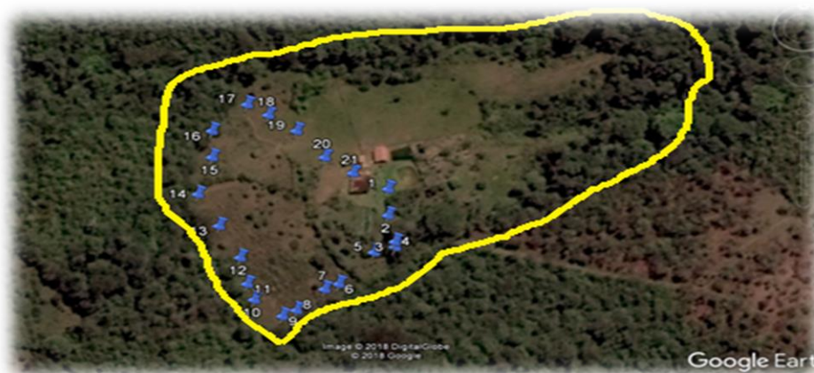
Fotografía 7. Área de captación de aguas lluvias, Finca La Fortuna.
