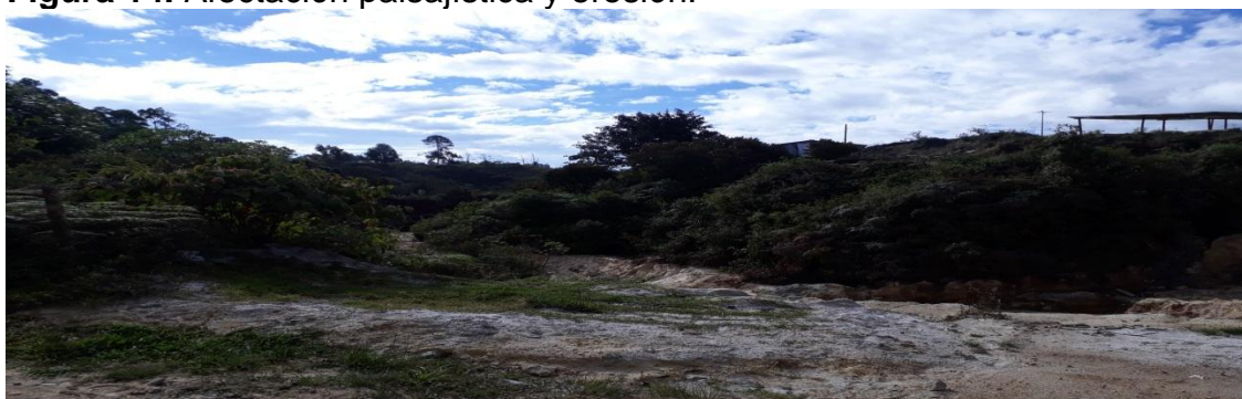
Figura 14. Afectación paisajística y erosión.
