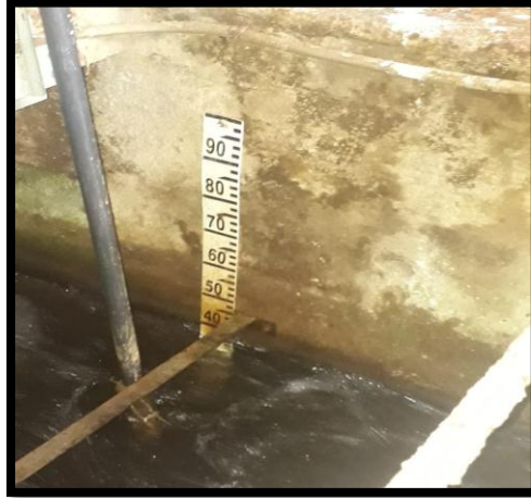
Figura 8. Altura de la lámina de agua
