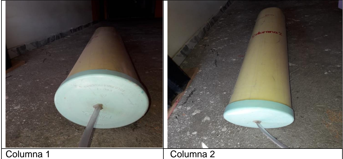
Figura 4. Construcción de las columnas piloto
