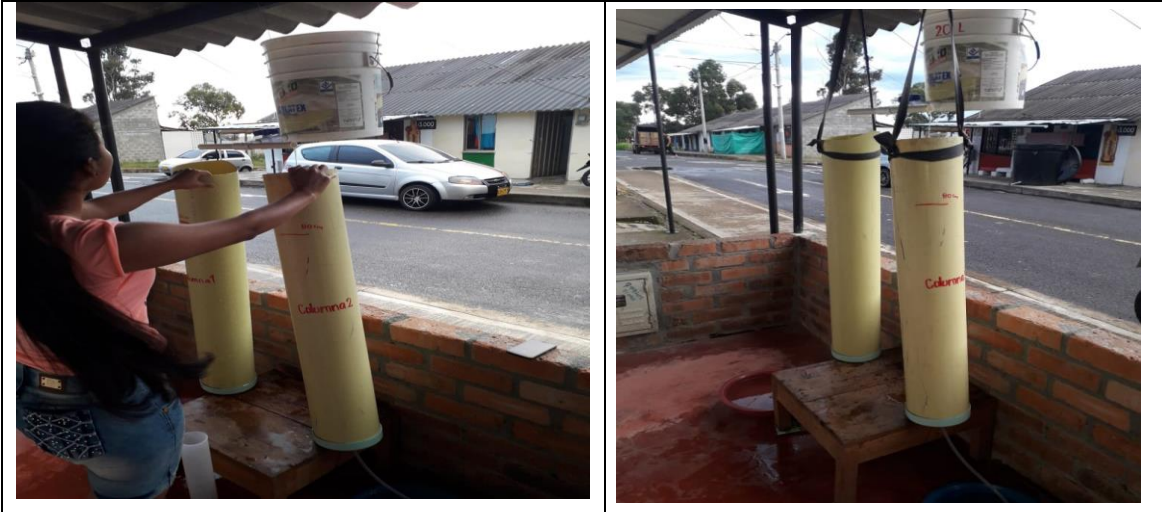
Figura 9. Instalación de las columnas y el alimentador
