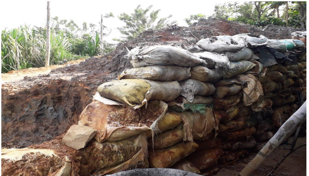
Anexo 6. Almacenamiento de lodos en plaza
