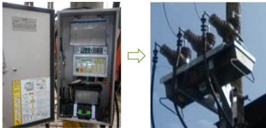
Figura 16. Controlador (Caja de Control) y unidad de interruptor (Caja de Polos)
