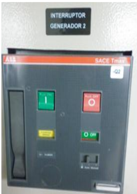
Figura 7. Interruptores unidades MTU 2,3 y 4
