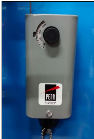
Fotografía 6: Termostato graduado a 130°F
