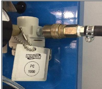
Fotografía 2: Conexión del suministro de aire.
