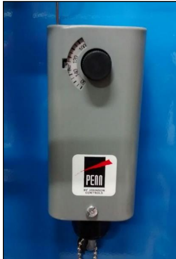
Fotografía 6: Termostato graduado a 130°F
