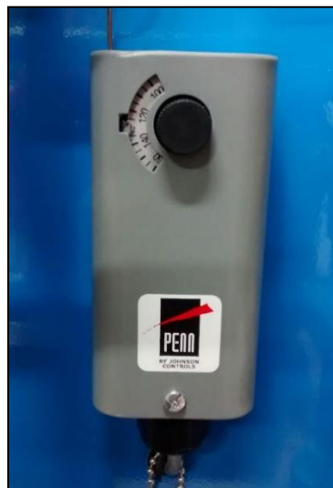
Fotografía 6: Termostato graduado a 130°F
