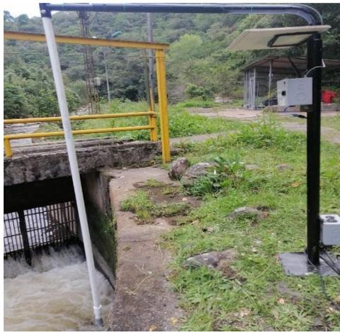
Figura 5.4. Instalación del sensor en la bocatoma del Río Cauca. Fuente propia
