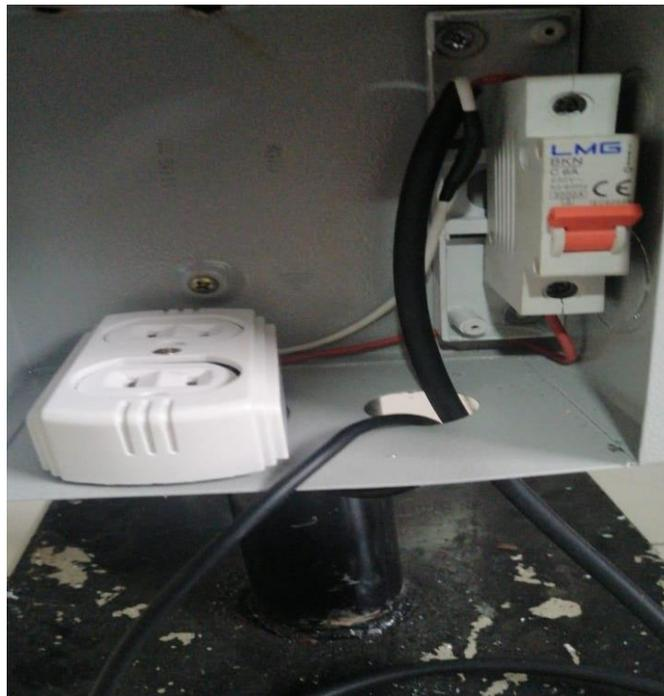
Figura 2 Cableado con toma de corriente y breaker de protección para la XBee y Sensor Ultrasónico en la infraestructura. Fuente propia
