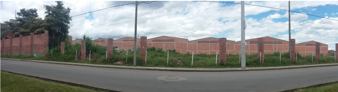
Ilustración 8: Lote de Construcción.
