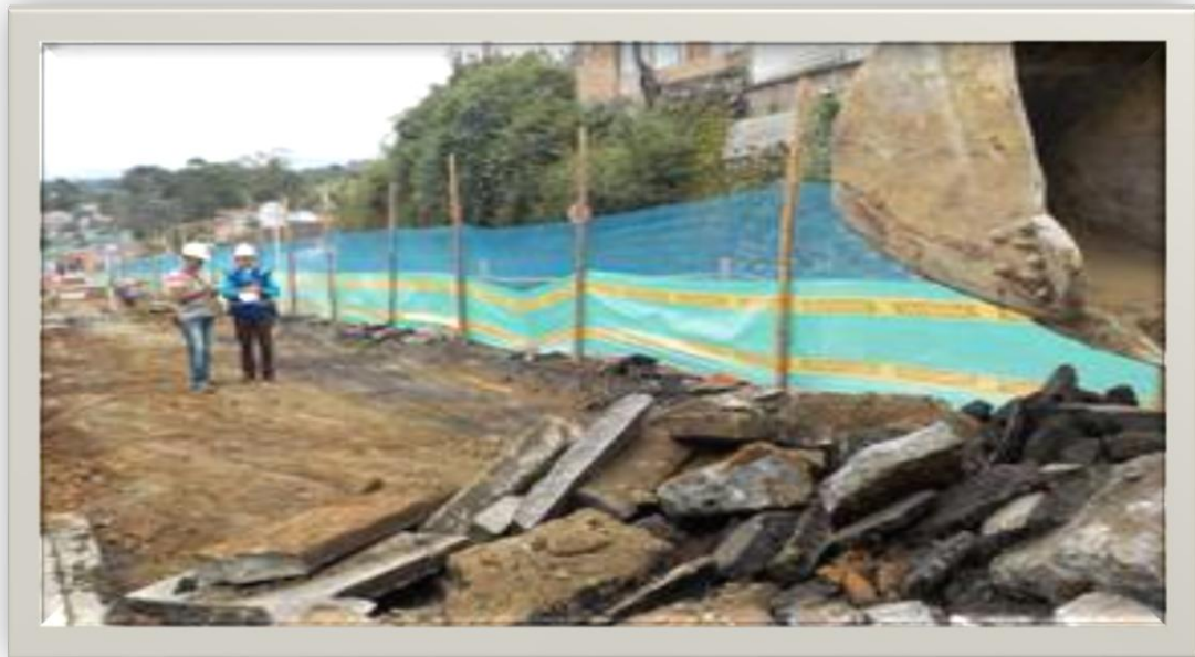
Fotografía 2. Excavaciones frente de obra.
