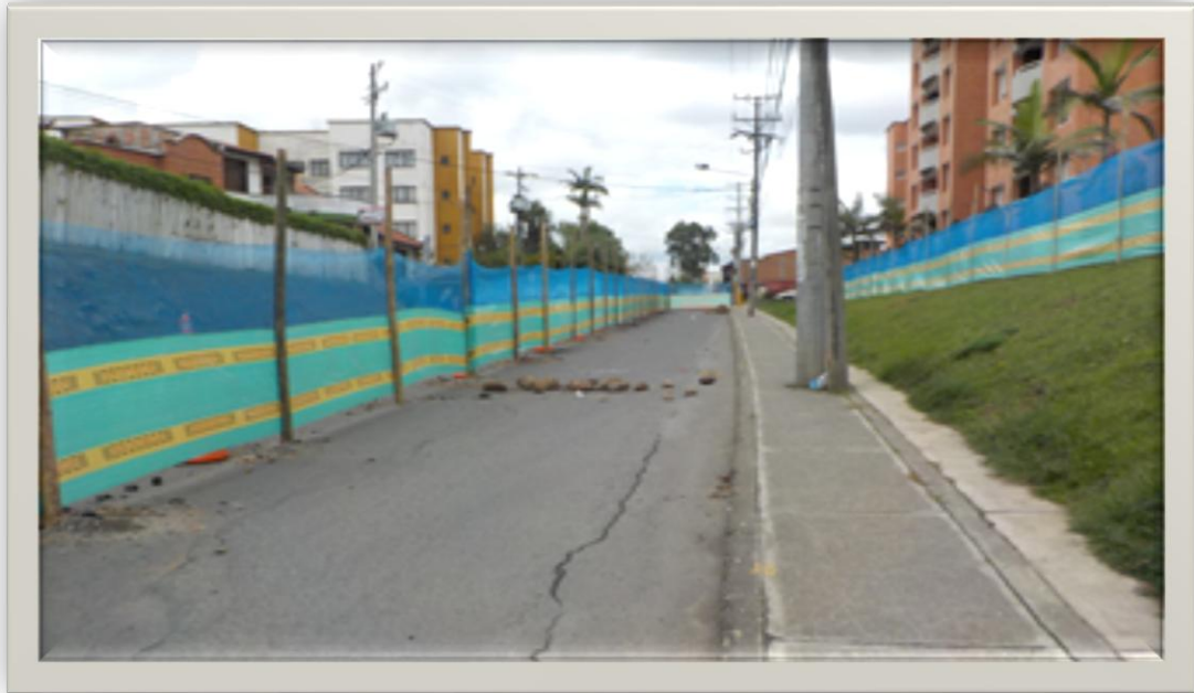
Fotografía 1. Cerramiento de obra.
