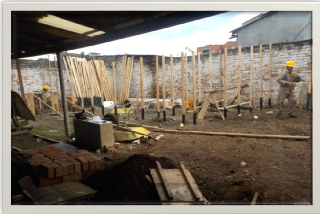
Fotografía 8. Instalación de Campamento para material y herramienta.
