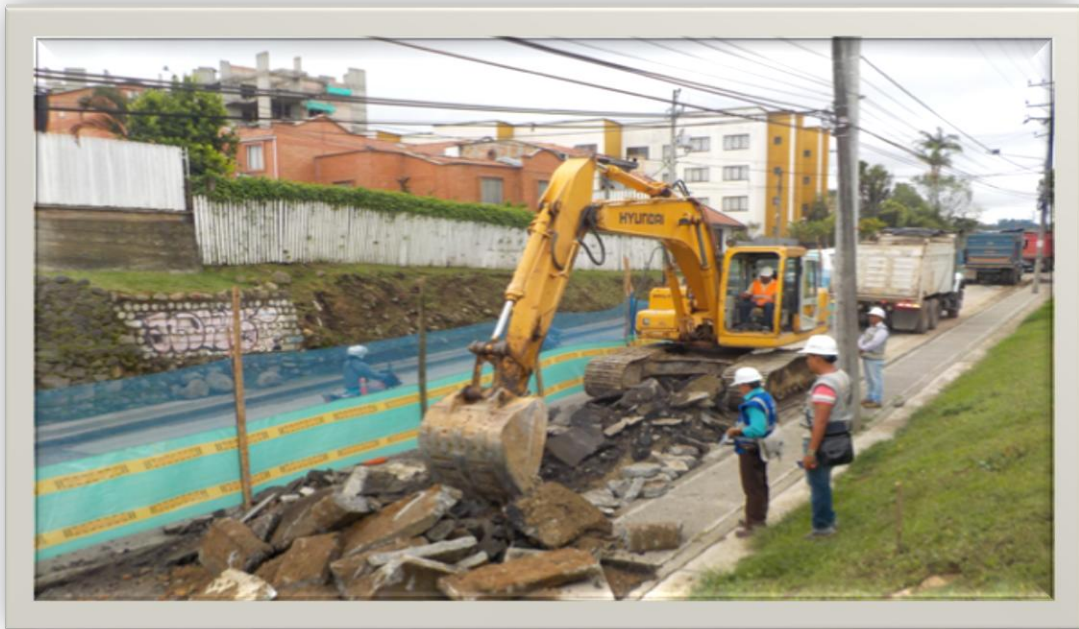
Fotografía 25. Excavaciones en frentes de obra.
