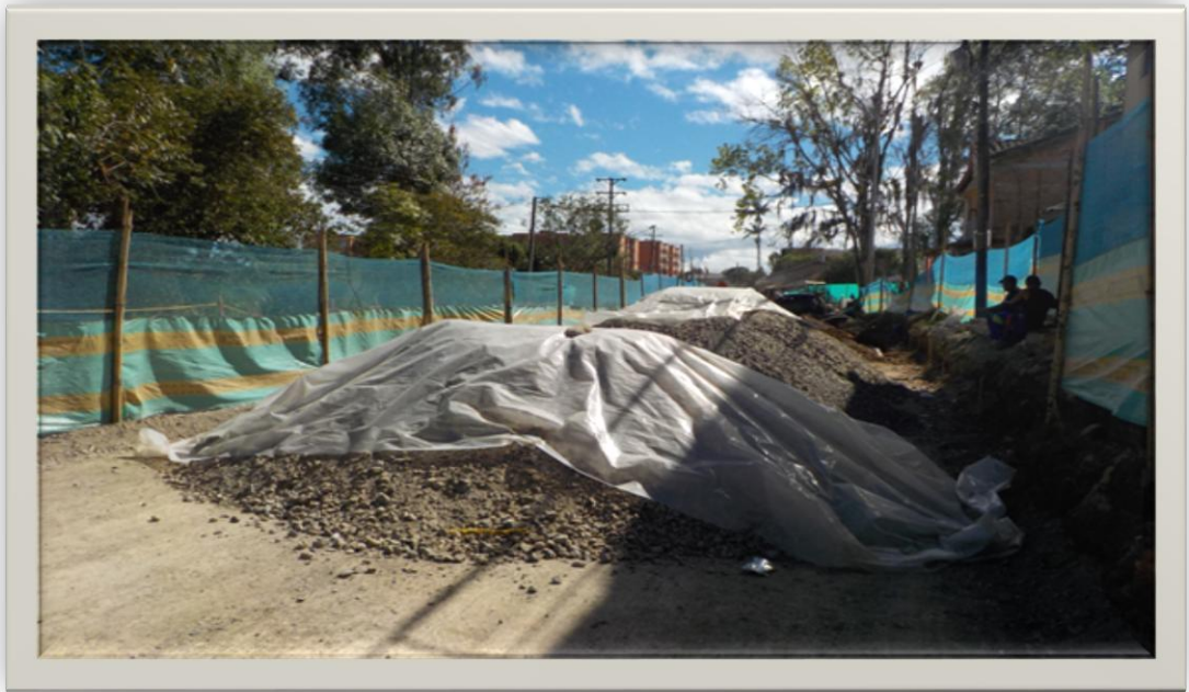
Fotografía 5. Almacenamiento y cubrimiento de subbase Granular.
