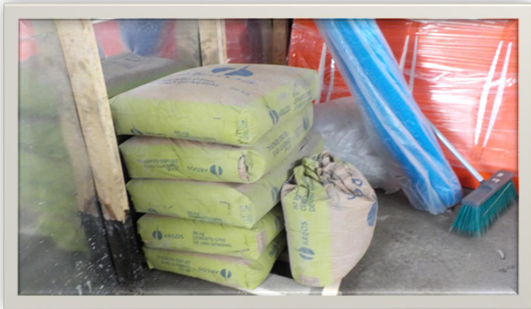
Fotografía 4. Almacenamiento de Cemento.
