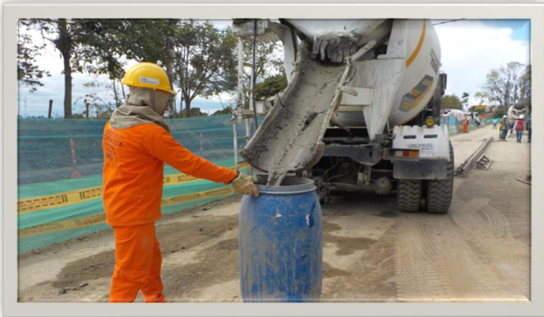
Fotografía 13. Lavado de mixer.
